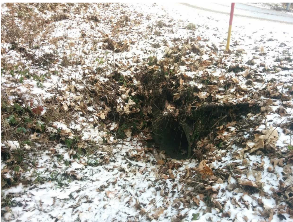
Slika 19: Pogled na prepust št. 1
